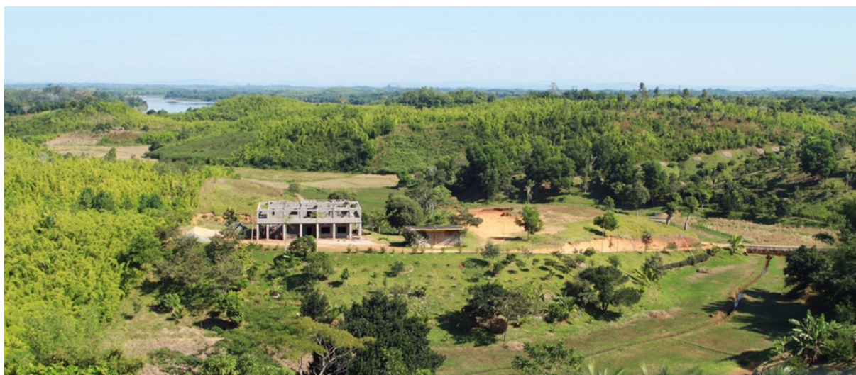
le site vu depuis la plate-forme des bâtiments d'hospitalisation
