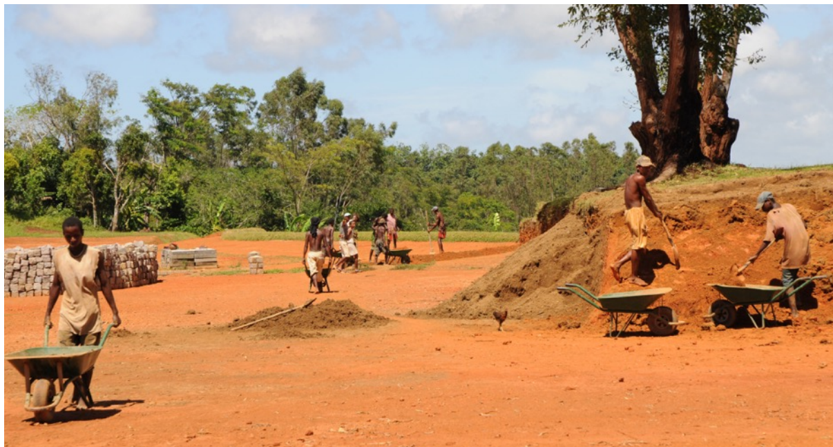
terrassement de la plate-forme principale
