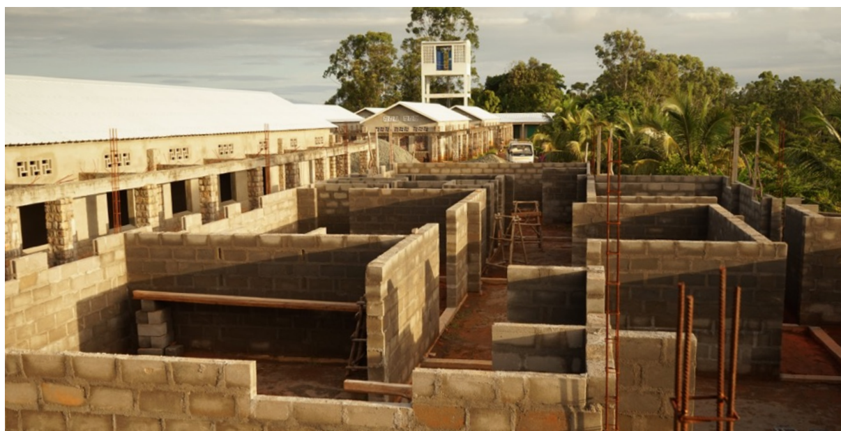
bloc opératoire en cours - au fond les locaux d'hospitalisation
