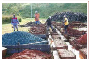
Fondations du bâtiment de stockage
