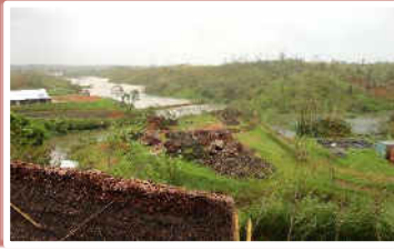
Après le passage des cyclones. Vue sur les cases détruites. À l'arrière, le fleuve Mananjry.
